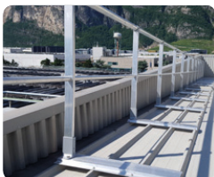
Balustradă ancorată de membrane hidroizolatoare prin sudură
